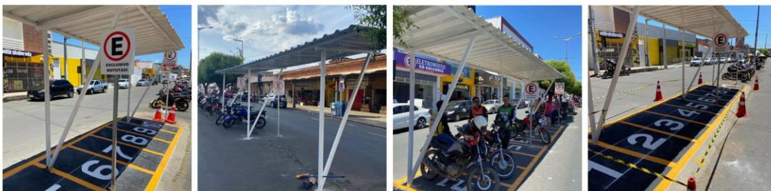
Aquisição de tintas de demarcação viária, utilizadas pelo setor de sinalização para implantação e revitalização de sinalização horizontal de faixas de pedestres, área de conflito, guia de calçada - esquinas, bolsões de motos, rampas de acessibilidade, área de demarcação de estacionamentos, canteiros, faixas de canalização, pontos de moto taxi, táxi e quebra-molas, nas ruas e avenidas da cidade.
