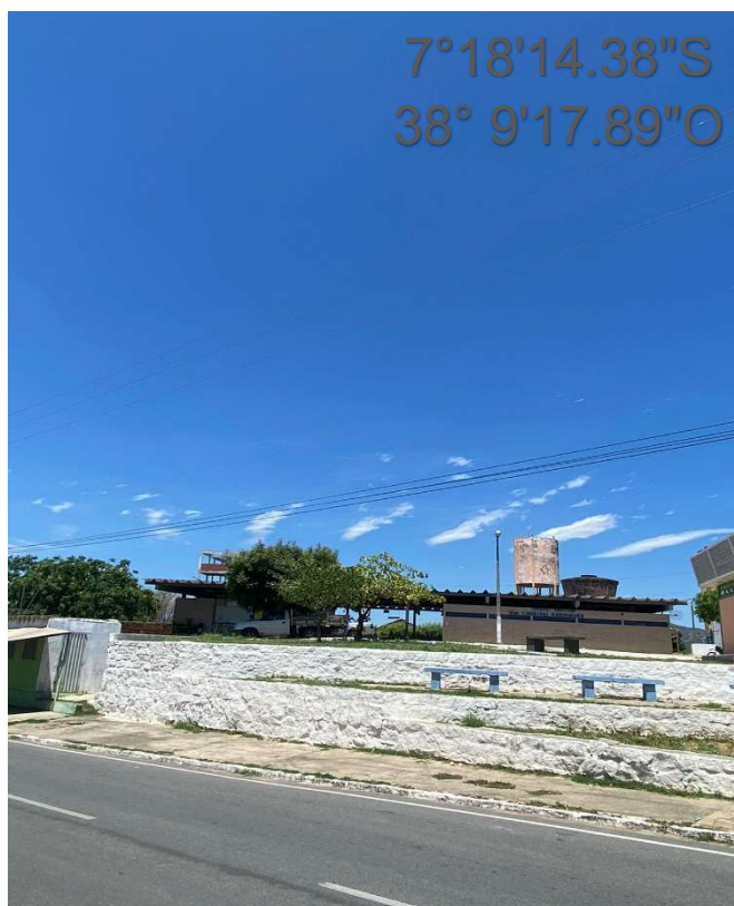
Imagem 7 (fotografia da rodoviária)
