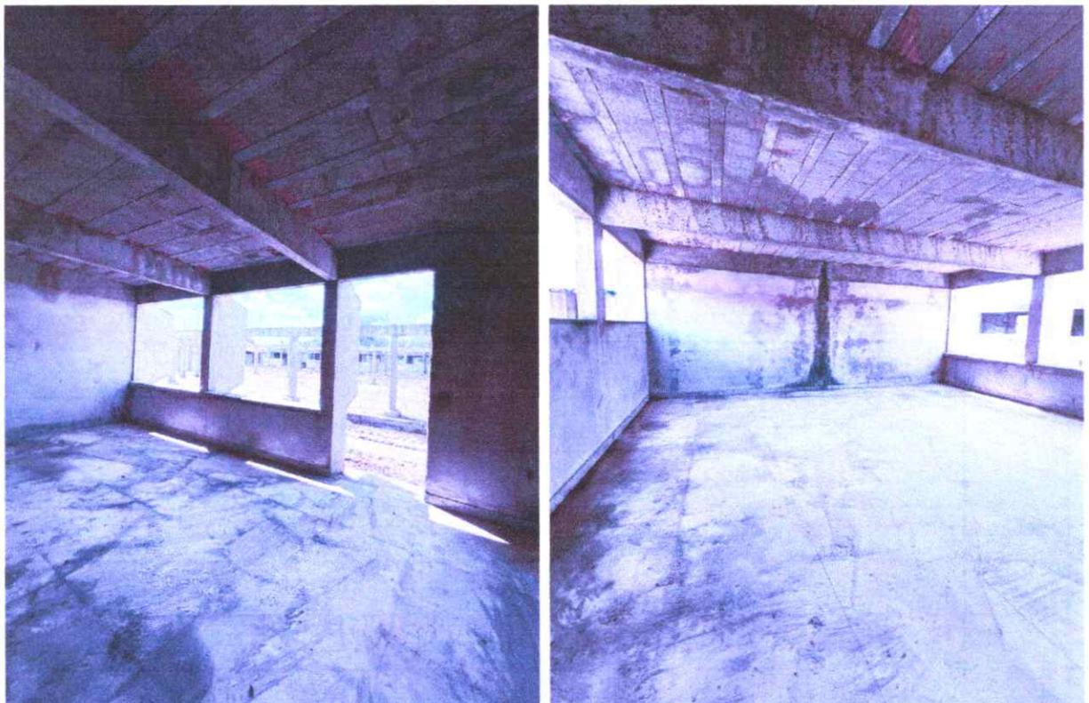
Figura 42 e 43 – Região interna do Bloco F com chapisco e reboco executados, contrapiso nivelado e aberturas para futuras esquadrias. Também é possível encontrar a presença de poeira e sujidades, que não comprometem na qualidade da infraestrutura e são fáceis de serem removidas por varrição. Fonte: Elaboração Própria.
