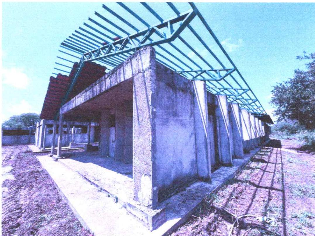
Figura 55 – Área externa do Bloco E2 com sua infraestrutura preservada e cobertura parcialmente executada. No entorno é possível ver um terreno nivelado e limpo. Também é possível verificar as faces das paredes rebocadas, limpas, niveladas, contrapiso executado e pilares estruturais íntegros. Fonte: Elaboração Própria.
