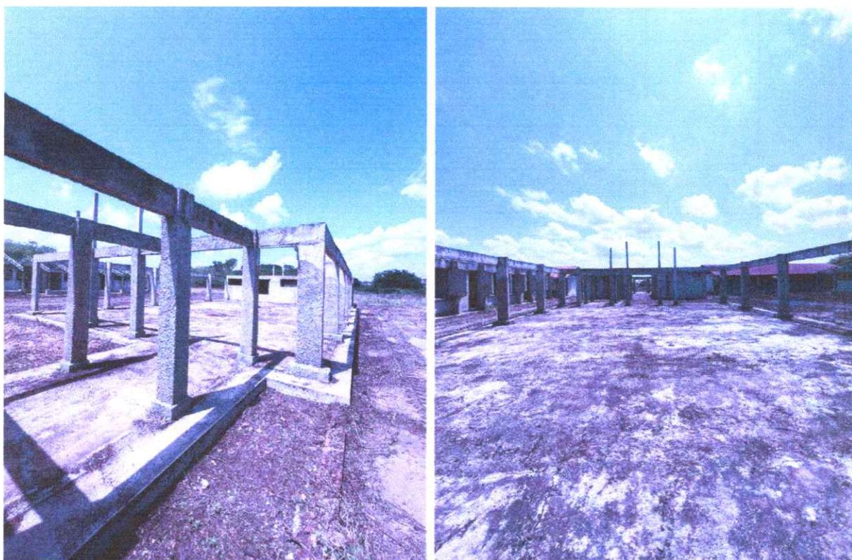
Figura 14 e 15 – Bloco D externo com estrutura em concreto armado preservada, limpa, com entorno e contrapiso nivelado e ausência de vegetação. Fonte: elaboração própria.
