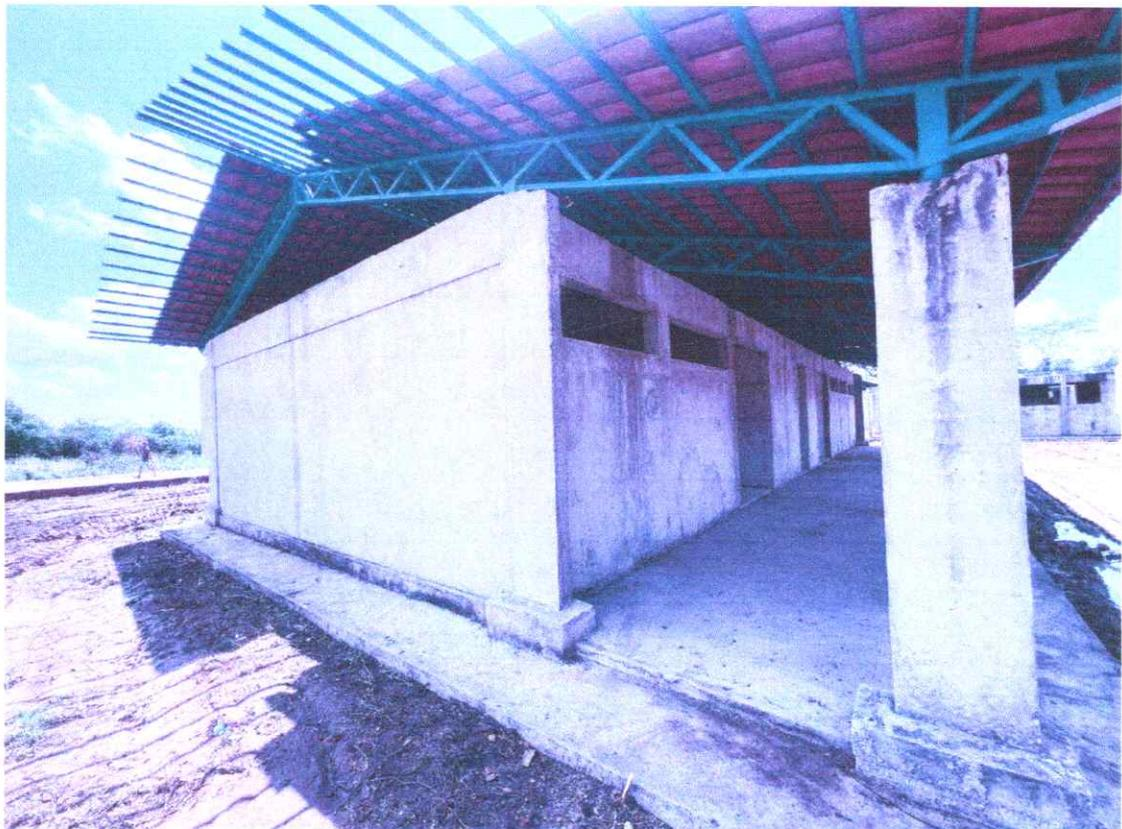
Figura 52 – Área externa do Bloco B com sua infraestrutura preservada, limpa e cobertura executada. No entorno é possível ver um terreno nivelado e limpo. Também é possível verificar as faces das paredes rebocadas, niveladas, contrapiso executado e pilares estruturais íntegros. Fonte: Elaboração Própria.
