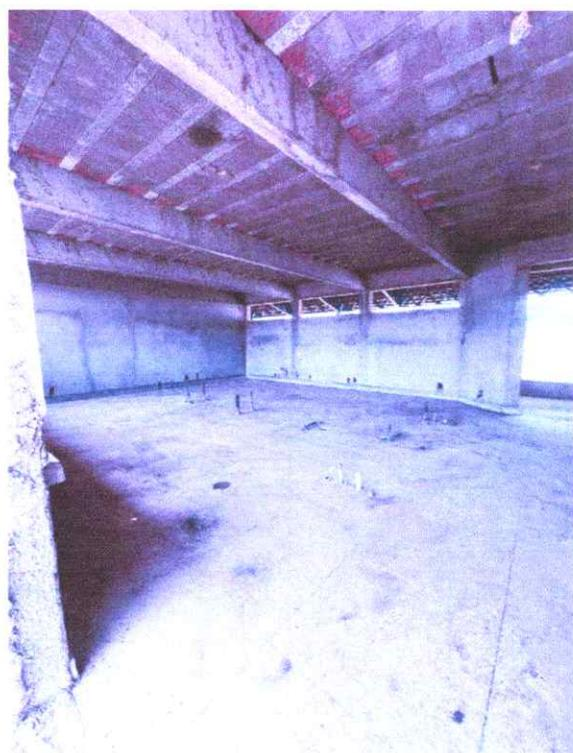
Figura 22 e 23 – Bloco C interno com estrutura preservada, limpa, contrapiso nivelado e paredes rebocadas. Aberturas existentes para esquadrias. Presença de pontos elétricos e outros para instalações prediais. Fonte: Elaboração Própria.
