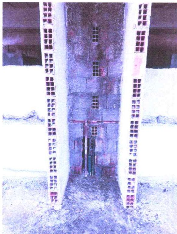
Figura 35 e 36 – Bloco D interno com estrutura preservada, limpa, contrapiso nivelado, paredes parcialmente rebocadas e com rasgos existentes para passagens de instalações prediais. Aberturas existentes para esquadrias e ventilação. Fonte: elaboração própria.
