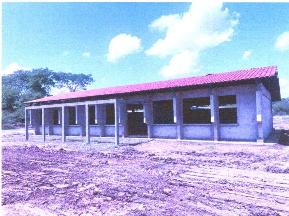
Figura 19 – Vista do Bloco C Pedagógico com cobertura finalizada, paredes rebocadas, contrapiso executado e nivelado e com estrutura preservada e limpa. Entorno do terreno nivelado e sem presença de vegetação. Fonte: Elaboração Própria.
