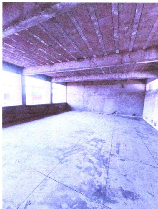
Figura 48 e 49 – Região interna do Bloco B com chapisco e reboco executados, contrapiso nivelado e aberturas para futuras esquadrias. Também é possível encontrar a presença de algumas caixas 4x2'' que serão utilizadas nas futuras instalações elétricas. Fonte: Elaboração Própria.
