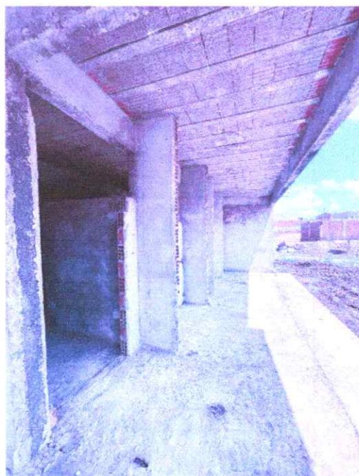
Figura 56 e 57 – Região externa do Bloco E2 com chapisco e reboco executados, contrapiso nivelado e aberturas para futuras esquadrias. As paredes encontram-se rebocadas, limpas e niveladas. Também é possível verificar a face inferior da coberta com sua estrutura íntegra e parcialmente executada. Fonte: Elaboração Própria.
