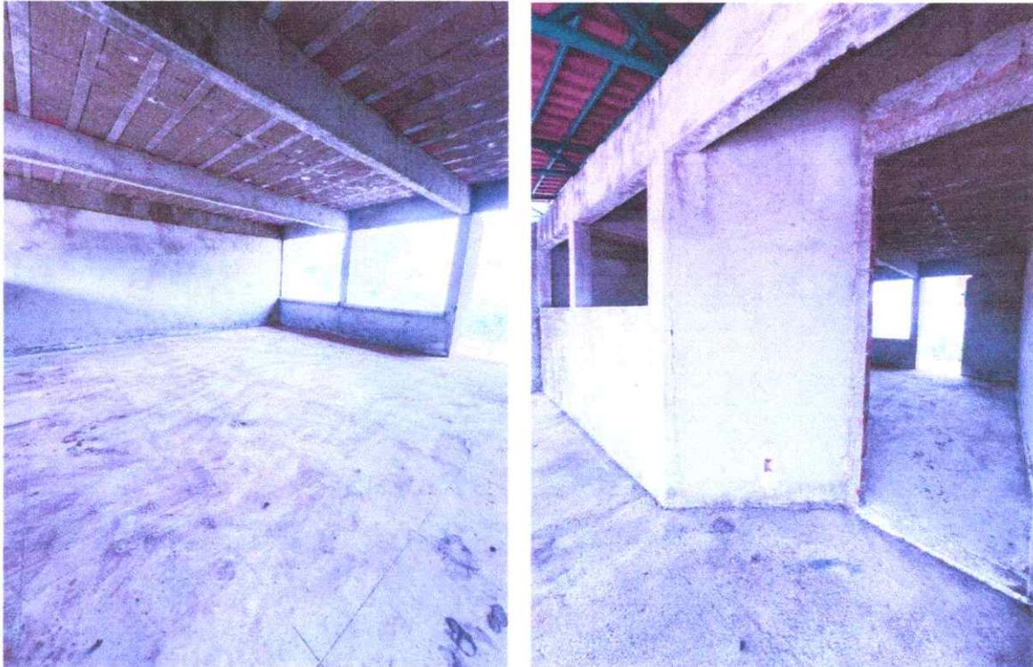
Figura 62 e 63 – Região interna do Bloco E2 com chapisco e reboco executados, contrapiso nivelado e aberturas para futuras esquadrias. As paredes encontram-se rebocadas, limpas e niveladas. Também é possível verificar a execução de algumas caixas de passagem 4x2'' para futuras instalações elétricas. Fonte: Elaboração Própria.
