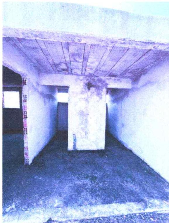
Figura 11 e 12 – Bloco A interno com estrutura preservada, limpa, contrapiso nivelado, paredes rebocadas e com rasgos existentes para passagens de instalações prediais . Fonte: Elaboração Própria.
