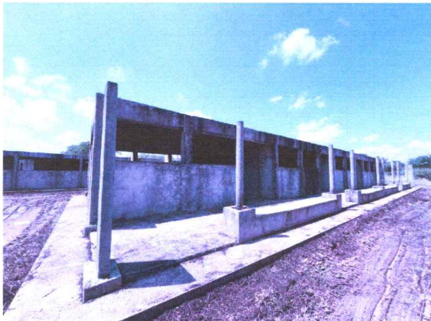
Figura 40 – Área externa do Bloco F com sua estrutura preservada, pilares executados e íntegros e contrapiso nivelado. Também é possível verificar a execução do reboco e aberturas para instalação das futuras esquadrias. O mesmo também apresenta um entorno nivelado, com solo sem vegetação e limpo. Fonte: elaboração própria.
